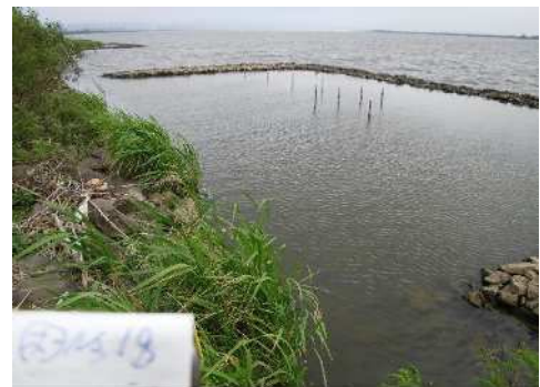
植生が回復していない消波工
